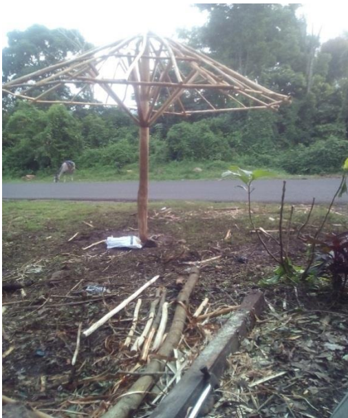
Foto 3. Construcción de Kiosko 2
