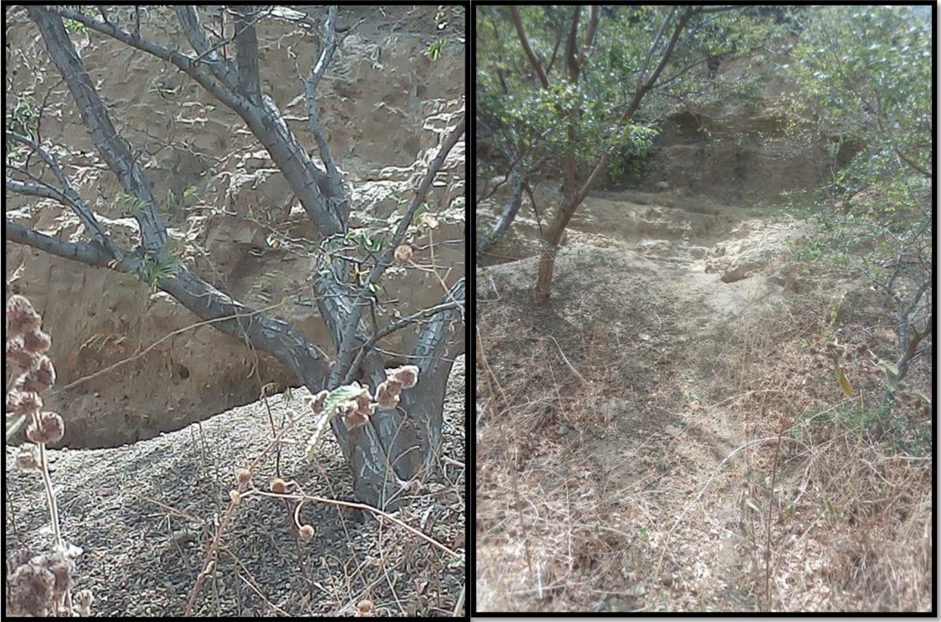
Figura 31: Segunda estación geológica inestabilidad en el talud.
