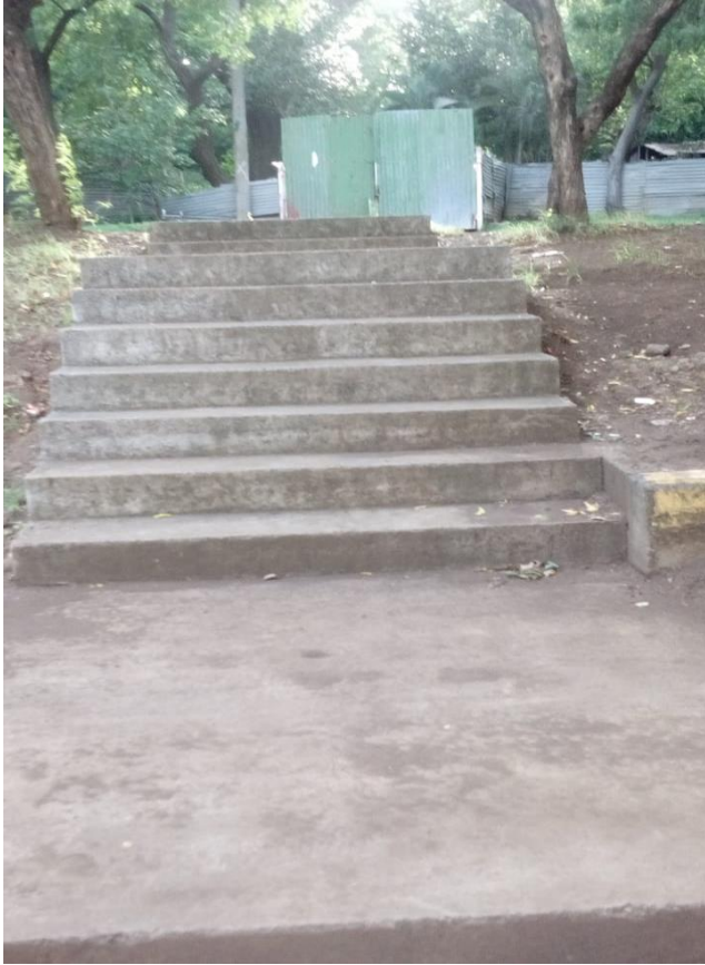
Ilustración 09. Escaleras de concreto pabellón 15.
