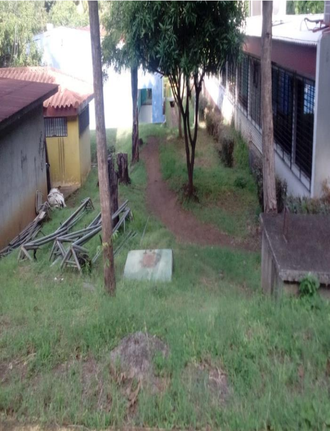
Ilustración 11. Falta de escaleras, para el acceso al Pabellón 21.
