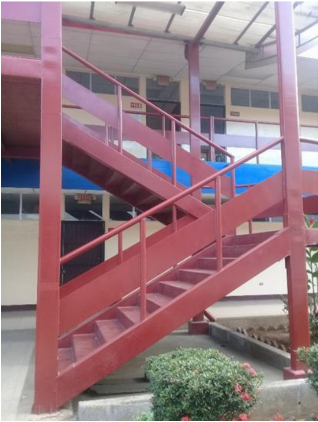
Ilustración 13. Vista Lateral, escaleras metálicas Pabellón 11.
