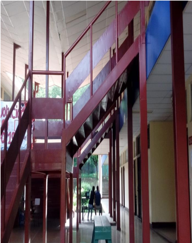
Ilustración 17. Vista Lateral, Escaleras Metálicas Pabellón 15.
