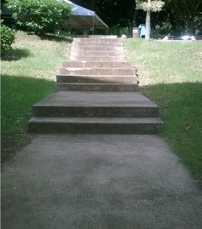
Ilustración 7. Escaleras de Concreto Pabellón 11.
