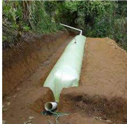
Figura 25: Biodigestor tipo tubular.
