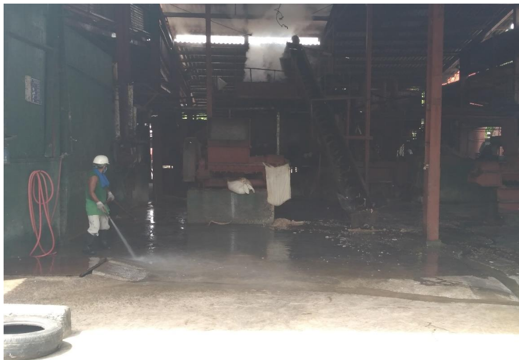
Ilustración 10 Recepción de materia prima.
