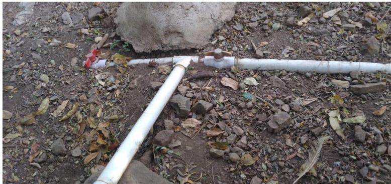
*Figura 10. Tubería en derivación para las casas.*
