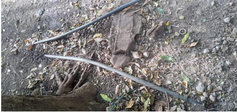
*Figura 11. Tuberías expuestas.*
