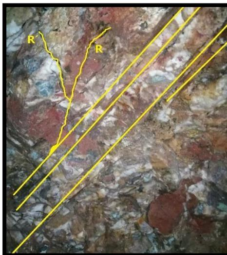
Figura 48. Se puede observar un desplazamiento con estructuras R y P y fracturas paralelas entre sí, con Rumbo en promedio Norte 35° Este y Buzamiento 39°, en el túnel que explota la veta High land Mery.
