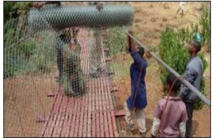
**Figura 11:** Colocación de malla.
