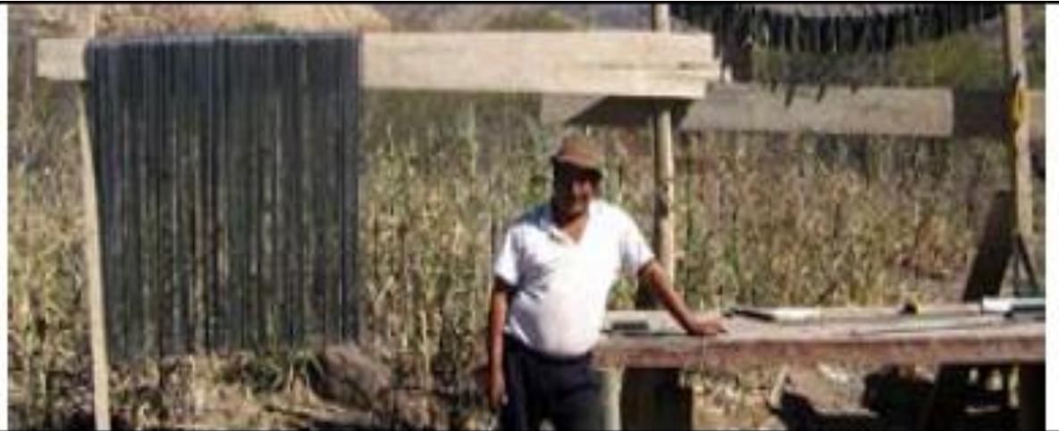
**Figura 9:** Realización de pendolones para tablero.
