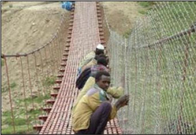
**Figura 10:** Colocación de malla.
