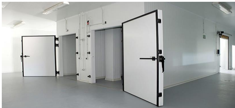
Ilustración 31. Cuarto frío para refrigeración de queso (Refriplast.com, 2020)
