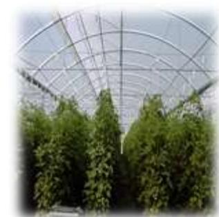
Un invernadero está formado por una estructura metálica o de plástico cubierta por materiales translúcidos para conseguir la máxima luminosidad en el interior. Dentro de este invernadero obtendremos unas condiciones artificiales (microclima) que genera a las plantas una mayor productividad con un mínimo coste y en menos tiempo.
