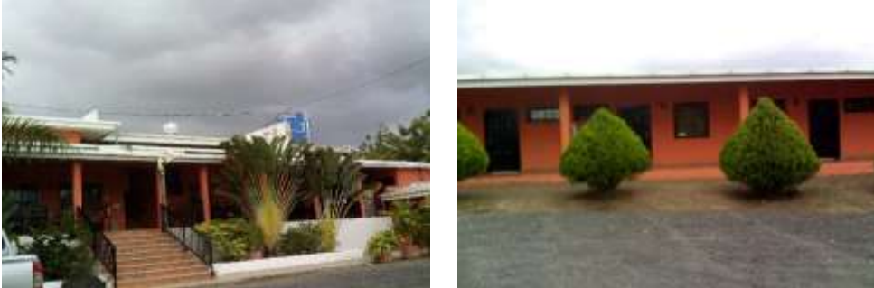
Imagen 13 . Ventanales y espacios abiertos para aprovechar luz y ventilación natural
