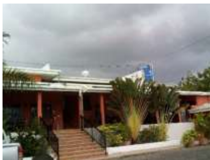
Imagen 18 Canales para el manejo de agua de lluvia
