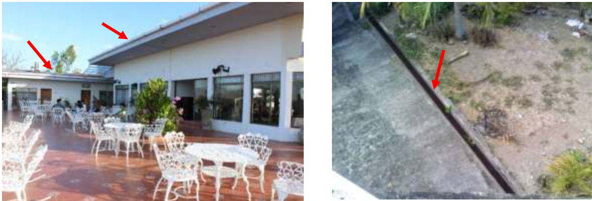
Imagen 39 Canales y canaletas para evacuación del agua pluvial, evitando erosión, lavado del suelo y escurrimiento por zonas de tránsito de las personas.
