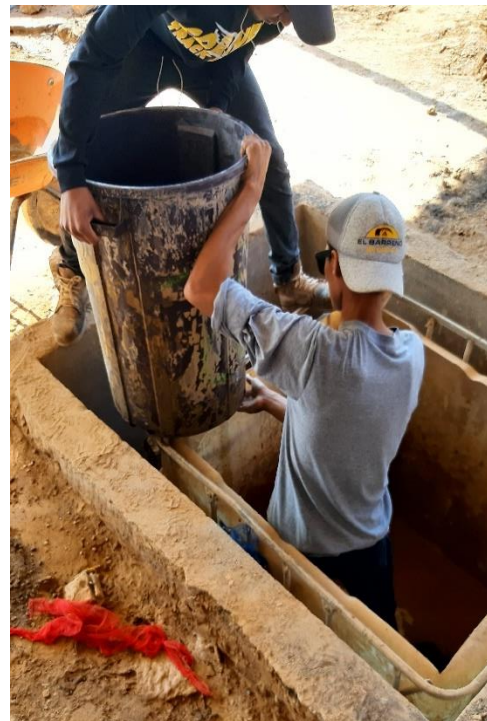
Foto 15: Instalación del carbón activado pasó 2
