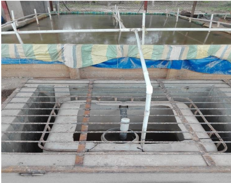
Foto 18: Pila de lixiviación y carbón activado
