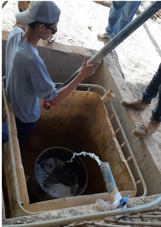
Foto 16: Instalación del carbón activado paso 3
