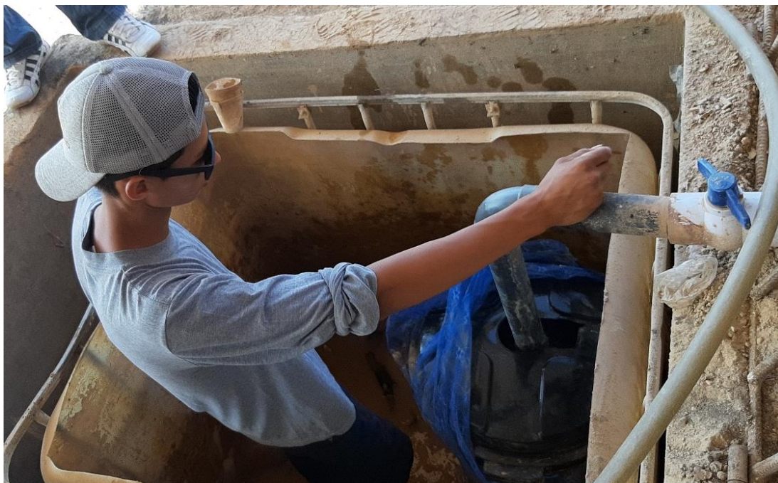
Foto 17: Instalación del carbón activado paso 4
