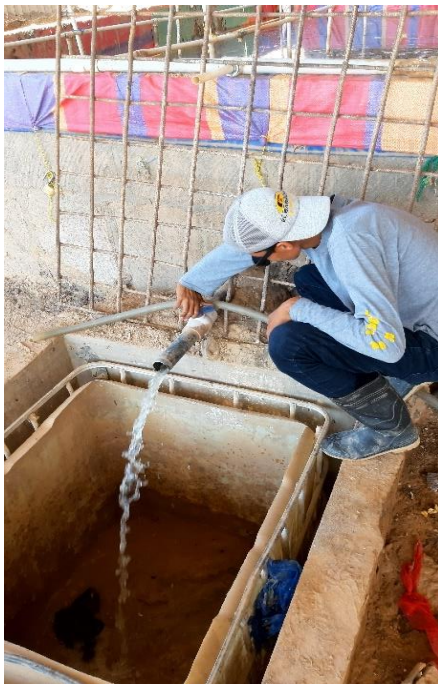
Foto 14: Instalación del carbón activado pasó 1
