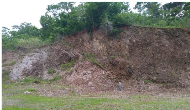
*Fotografía 18. Talud de roca andesita-basalto formado por la remoción de material para balastro. Comarca La Trinidad (E: 769479 / N: 1245768).*
