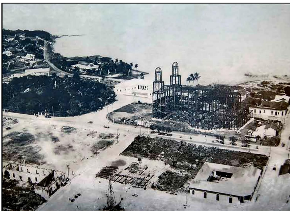
“Panorámica donde se puede apreciar la estructura de acero de la Catedral Metropolitana de Managua en construcción” (Patrimonio Cultural Alcaldía de Managua, 2010, pág. 32)
