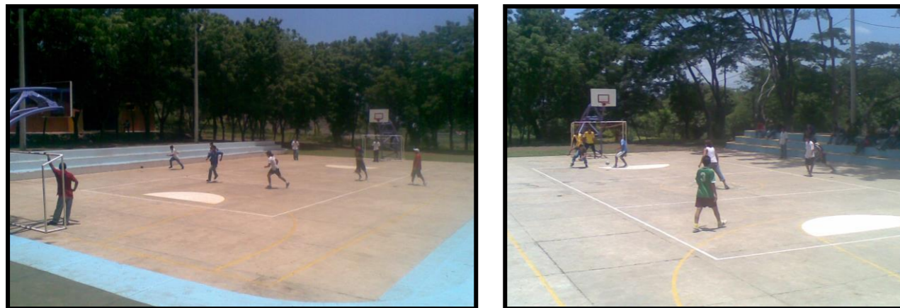
Imagen Nº. D.26 - 27: CANCHAS MULTIFUNCIONALES MARLON CELAYA.
