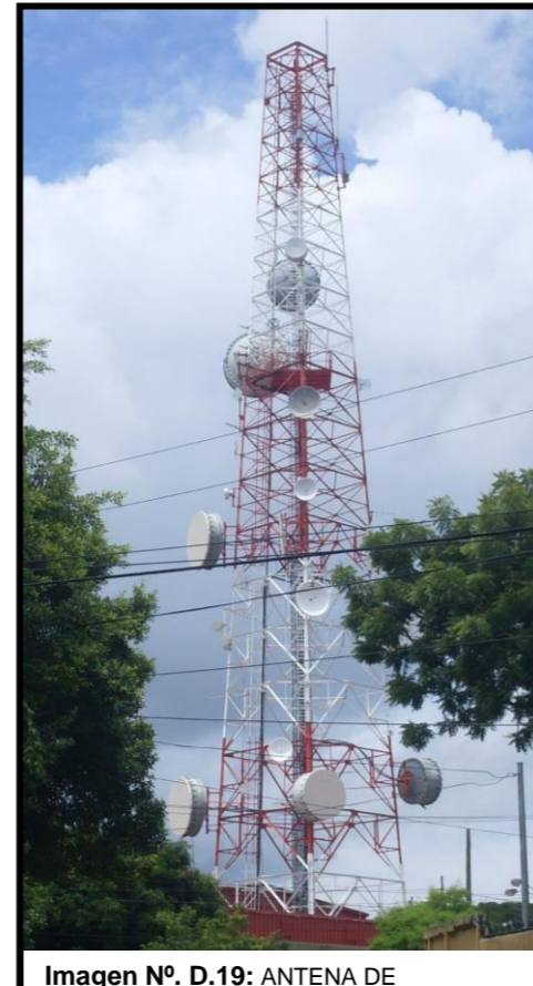
Imagen Nº. D.19: ANTENA DE TELECOMUNICACION CLARO VILLA FONTANA
