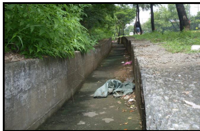
Imagen Nº. D.11: DRENAJE SANITARIO – CUNETAS EN U.
