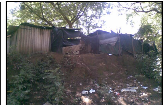
Imagen Nº. D.14: VIVIENDAS UBICADAS A ORILLA DE CAUCE
