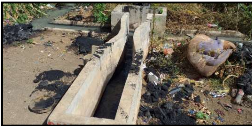
Figura 38. Efluente del Sistema colmatado, que descarga en el río Tipitapa, Barrio La Villa Tipitapa, 2018 (N:1349143, E:599608 a 53 msnm)
