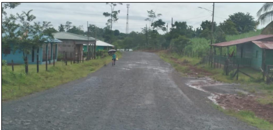
Foto No.9 Infraestructura vial – calle entrada a la comunidad La Aurora
