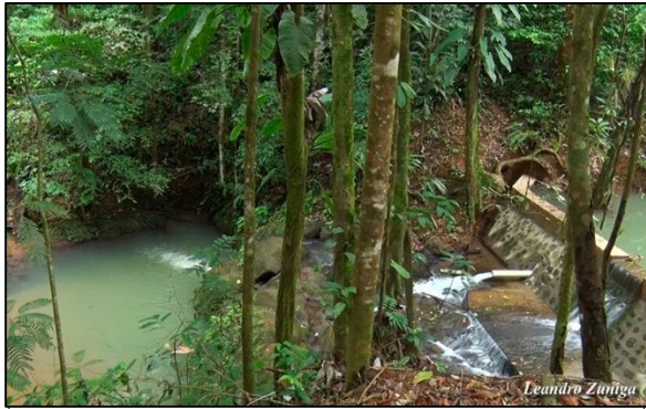
Foto No.6 Presa para la captación de agua que abastece a la comunidad La Aurora. Créditos Leandro Zuniga
