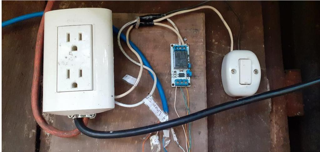
**Ilustración 24: Ubicación de módulo relé e interruptor manual de riego de riego.**
