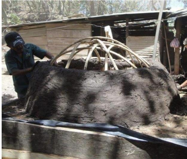
Figura 1. Horno tradicional para la producción de rosquillas, fuente: Barcus 2019.
