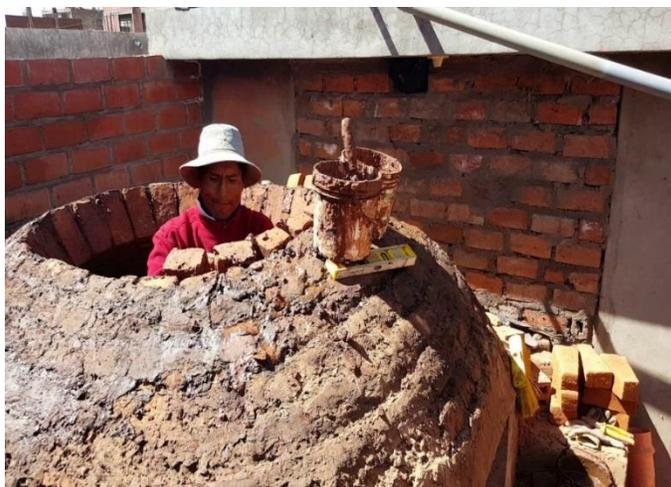
Figura 4. Construcción de horno tradicional, fuente: Simas, 2014.
