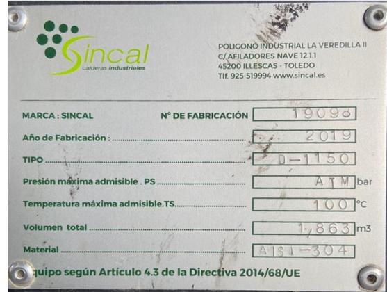
Ilustración 44 Especificaciones técnicas tanque de condensado instalado en HESJDE
