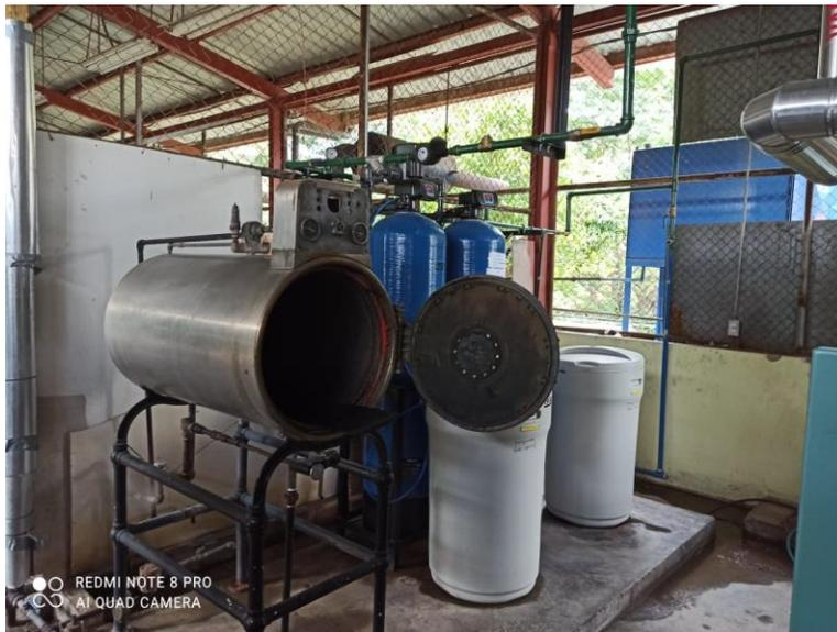
Foto 1 Autoclave de sala de máquinas
