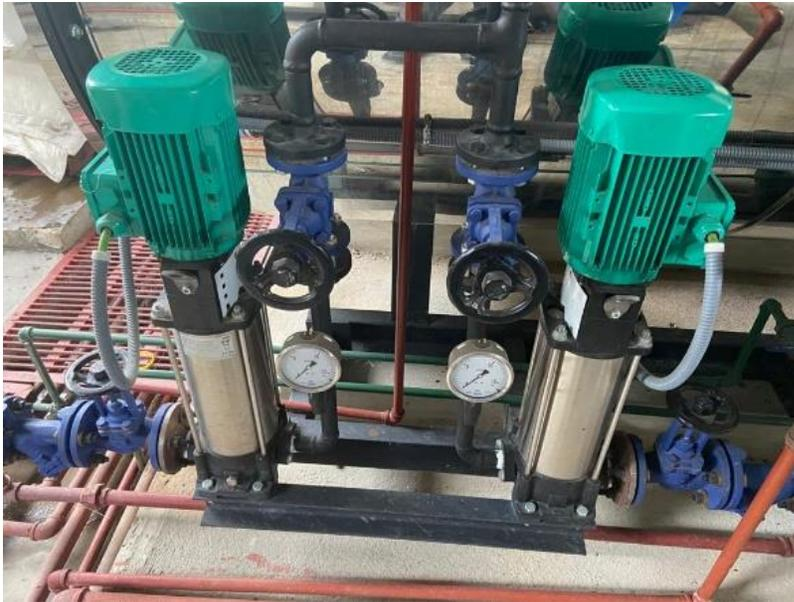
Ilustración 46 Bomba de alimentación de agua
