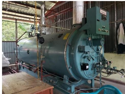
Ilustración 38 Generador pirotubular CleaverBrooks
