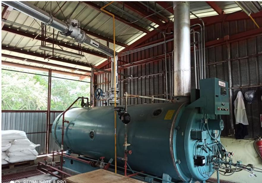
Ilustración 41 Caldera Cleaverbrooks CB 600 instalada en el HESJDE
