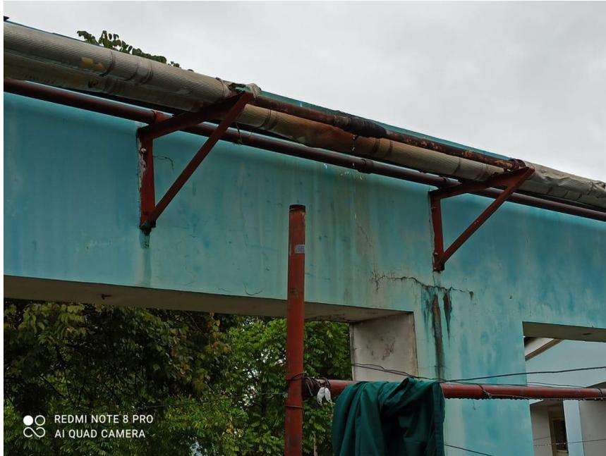
Ilustración 59 Fuga existente en línea de vapor
