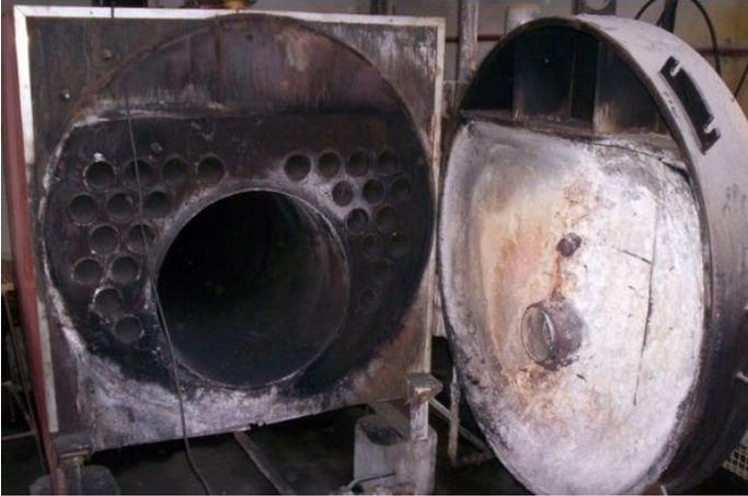
Ilustración 13 Mantenimiento de calderas
