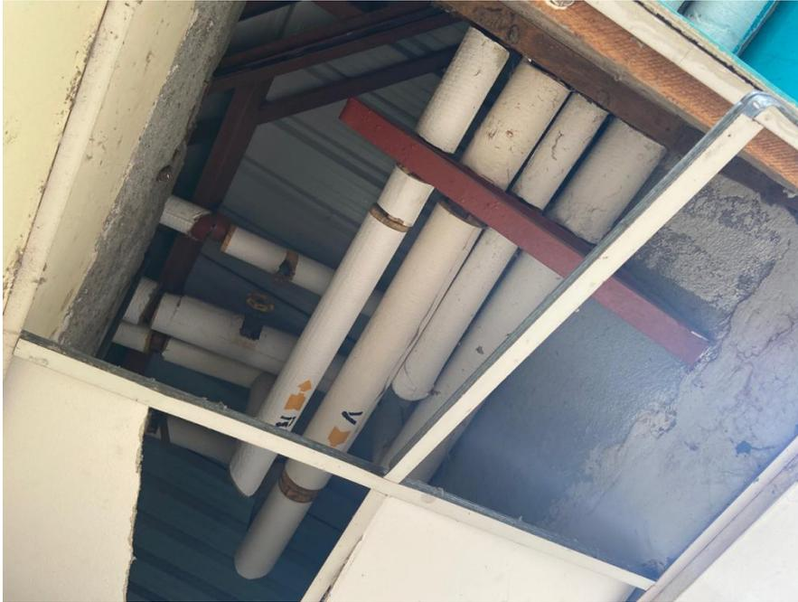
Ilustración 50 Tuberías sistema de distribución de vapor HESJDE
