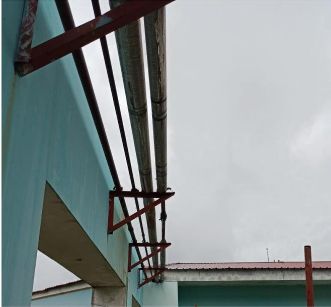
Ilustración 57 Tubería sin aislar
