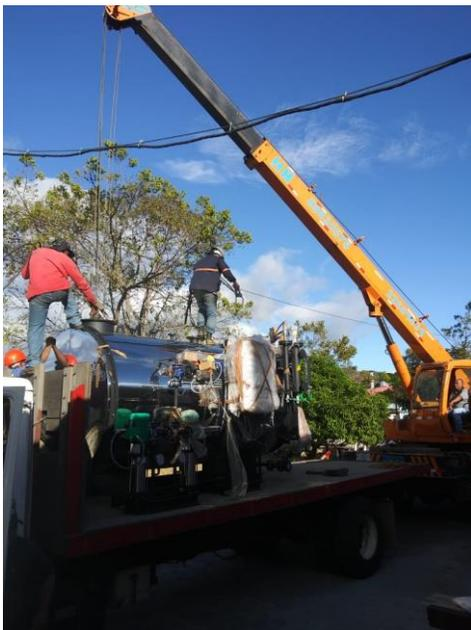
Ilustración 3 Instalación de la Caldera SINCAL tipo HD160
