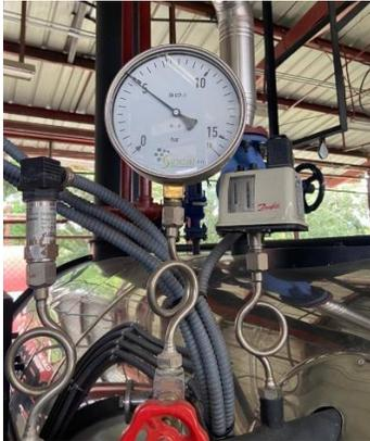
Ilustración 21 Manómetro
