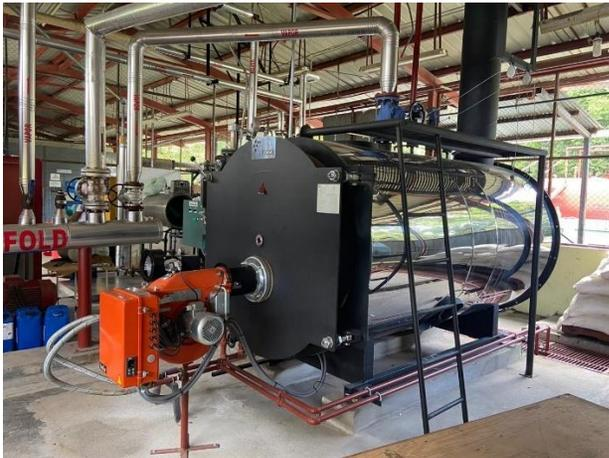
Ilustración 40 Caldera Sincal HD 160 instalada en el HESJDE
