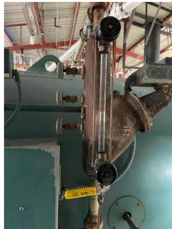
Ilustración 20 Indicador de nivel de agua del generador de vapor
