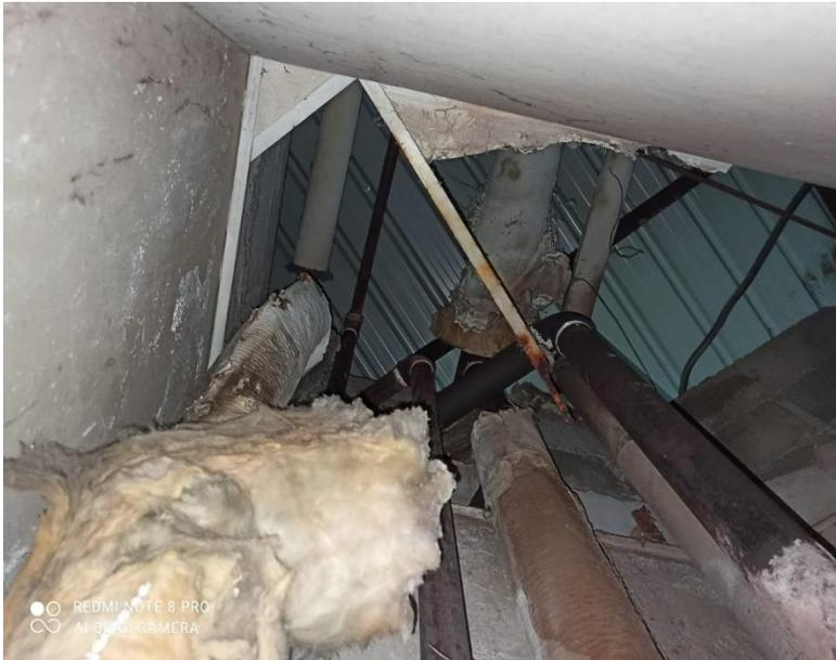
Ilustración 58 Tubería sin aislar
