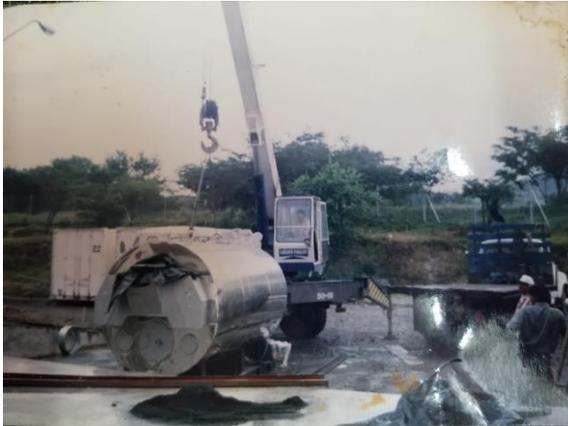
Ilustración 2 Instalación de Caldera VULCANO-SADECA modelo DDH-20
