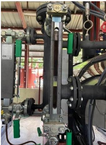
Ilustración 19 Indicador de nivel de combustible de caldera
