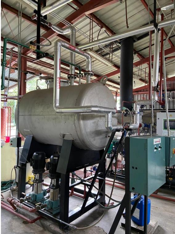
Ilustración 45 Tanque de condensado instalado en H.E.S.J.D.E
