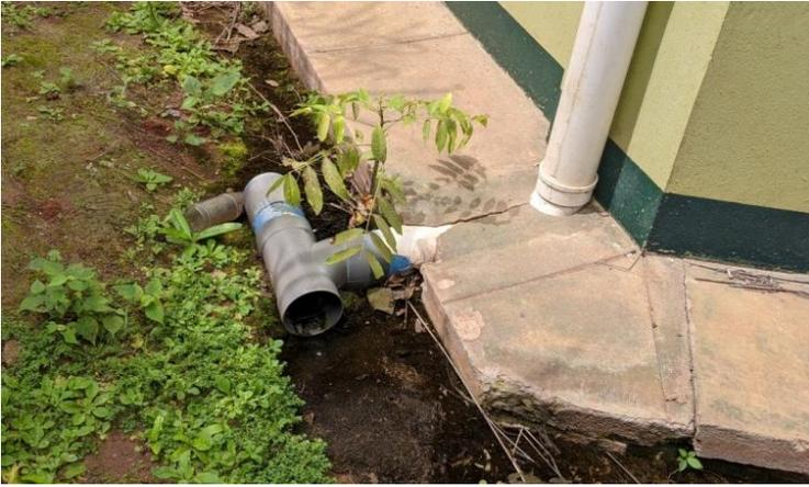
*Figura 20. Estado de tuberías*
