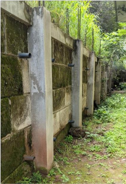
*Figura 22. Drenaje de muro*
