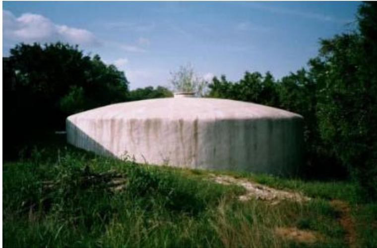
*Figura 9. Tanque de almacenamiento semienterrado en ferro-cemento
