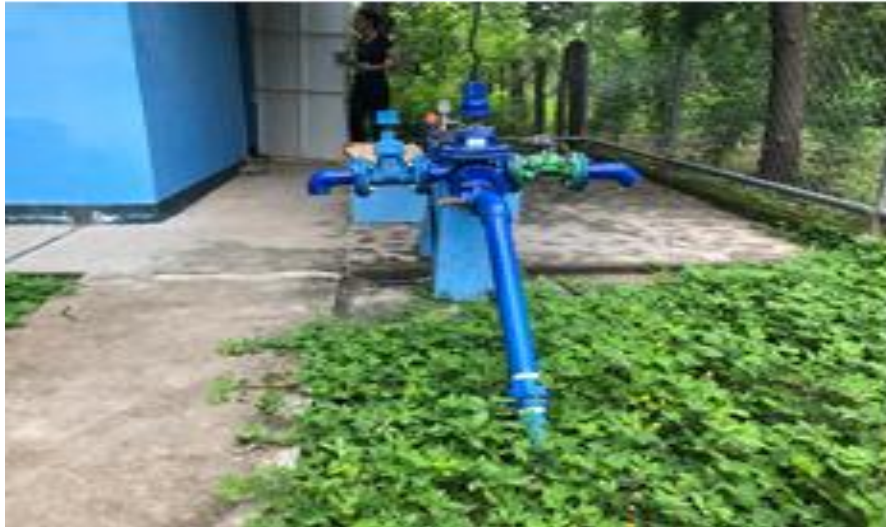
Figura No 11: Válvula de carga y descarga
