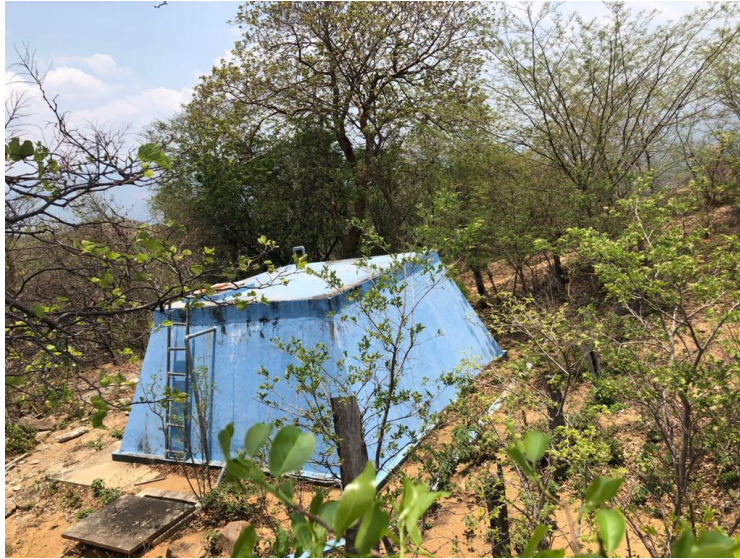
Figura No 10: Sistema de almacenamiento de 13 m 3
