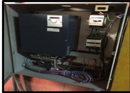
*Figura 30* Variador de frecuencia Fuente: Etimaquinarias S.A
