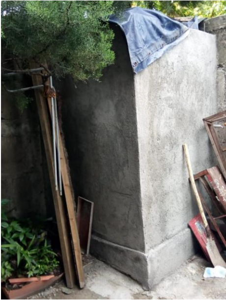
Figura 36. Pila con agua potable dentro de la planta procesadora de agua
