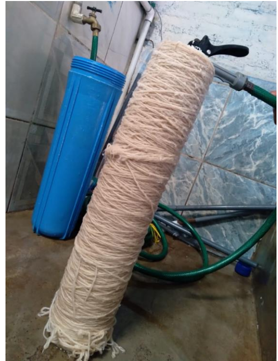
Figura 29. Filtros en proceso de limpieza y desinfección
