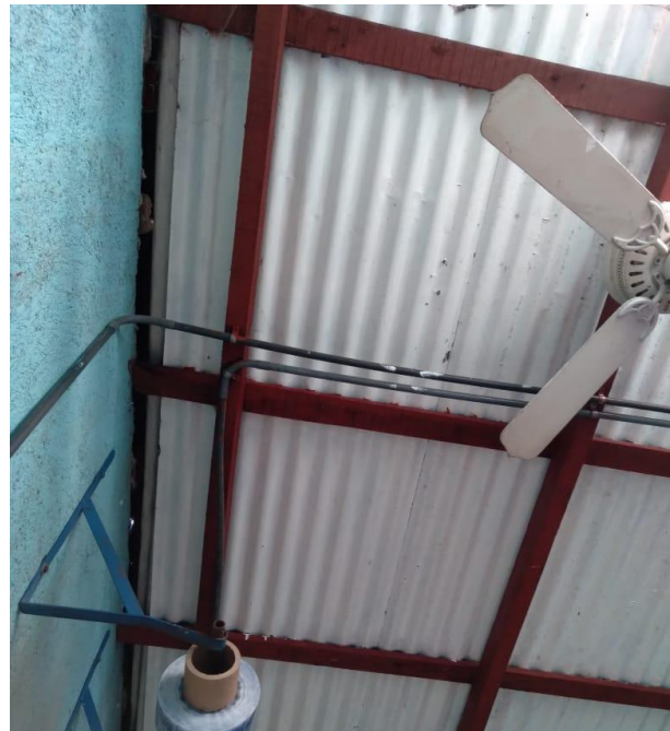
Figura 15. Ventilación artificial poco adecuada en el área de embolsado
