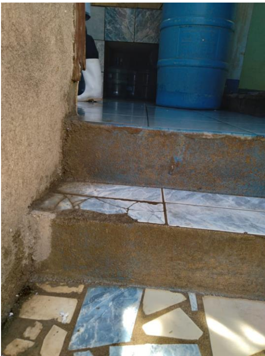
Figura 12. Gradas sin antideslizantes y de un material inadecuado, en el área de lavado
