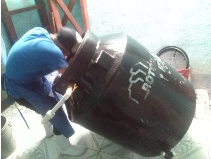
Figura 22. Limpieza y desinfección de tanques
