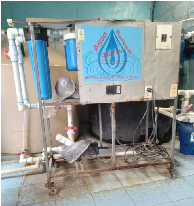
Figura 38. Planta Procesadora de purificación de agua
