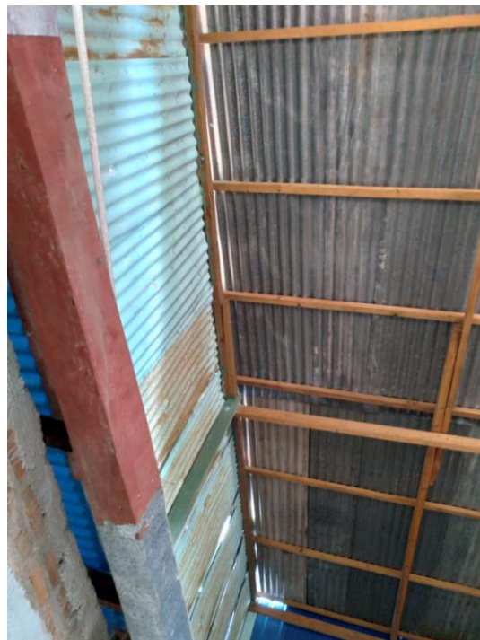
Figura 13. Techo no adecuado, del área de producto terminado
