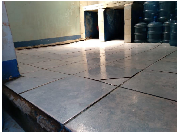
Figura 9. Pisos con desnivel en el área de llenado
