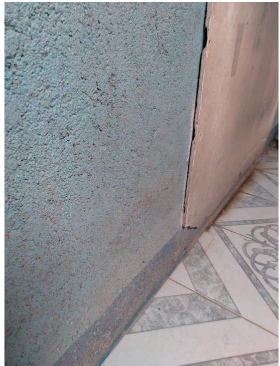
Figura 11. Pared del área de empacado, material no absorbente, liso ni fácil de lavar
