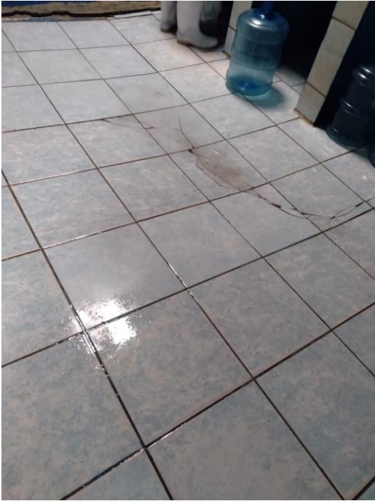
Figura 10. Pisos con grietas y uniones en el área de llenado.
