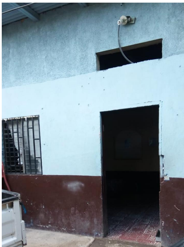
Figura 14. Pared del área de empaclado, material no absorbente, lisos ni fácil de lavar
