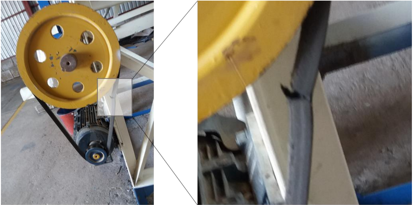
Ilustración 44. Ejemplo de falla. Fuente: Gira de campo.
