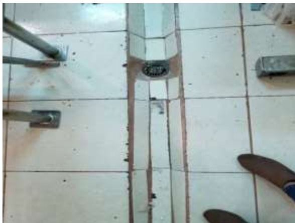
Imagen 4. Canales de desagües para el suero. Fuente: Propia.
