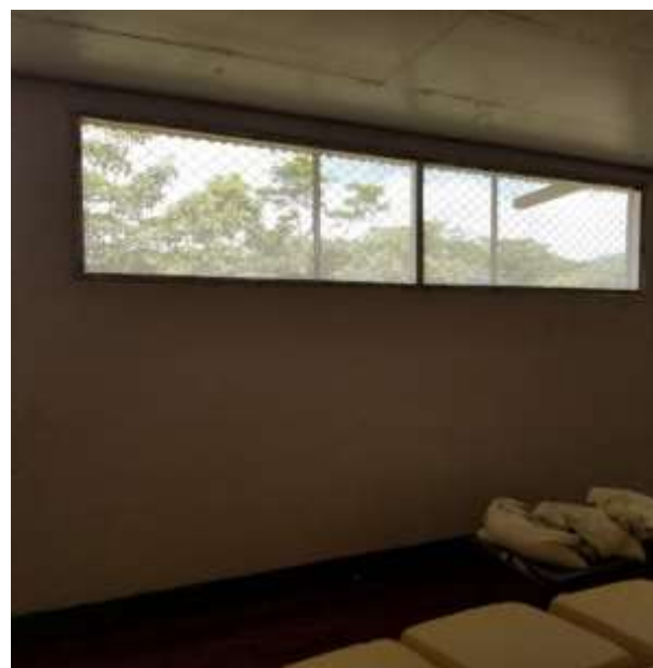
Imagen 8. Ventilación, paredes y techo. Fuente: Propia.
