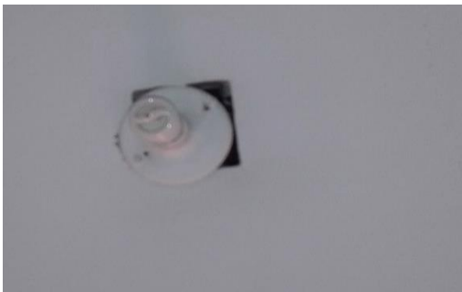
Figura 15. Ruptura sin acabado. Fuente: Propia
