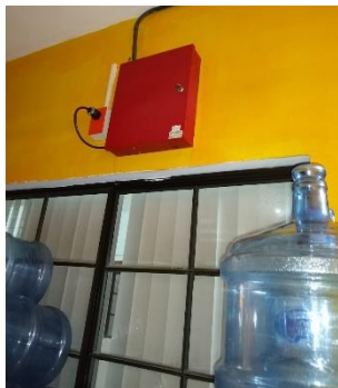
Figura 35. Obstrucción de ventanas. Fuente: Propia
