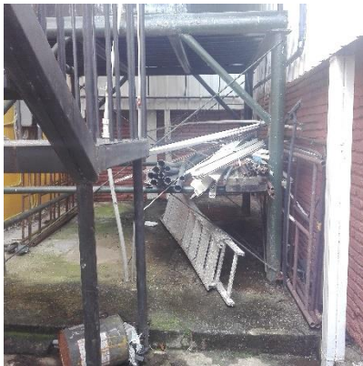
Figura 45. Materiales mal ubicados
