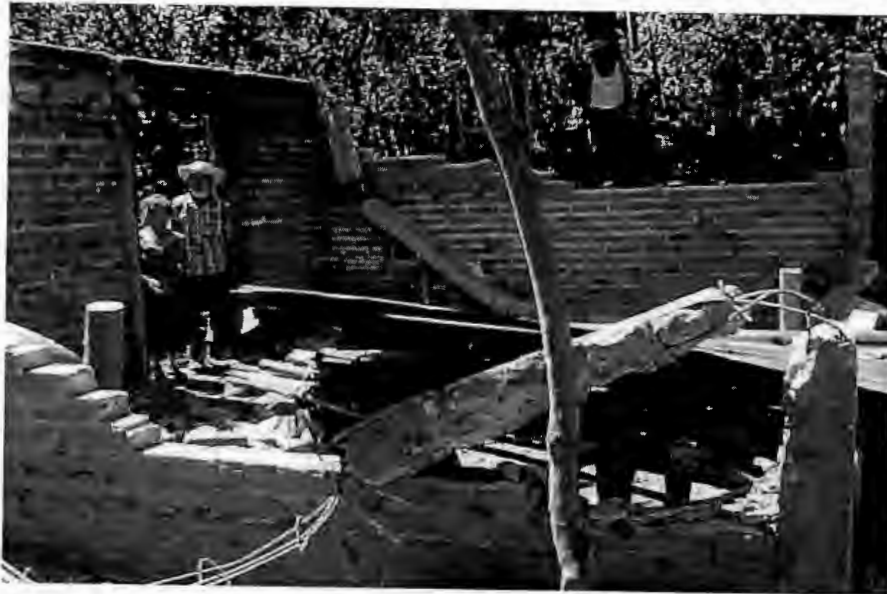
Imagen01.- Vivienda destruida a consecuencia del terremoto del 13 de febrero del año 2001, Departamento de San Vicente, El Salvador.
