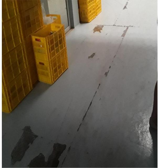
*Figura 26.* Fisuras en el piso
