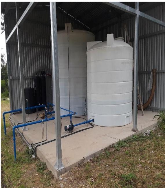
*Figura 15.* Tanques de tratamiento de agua
