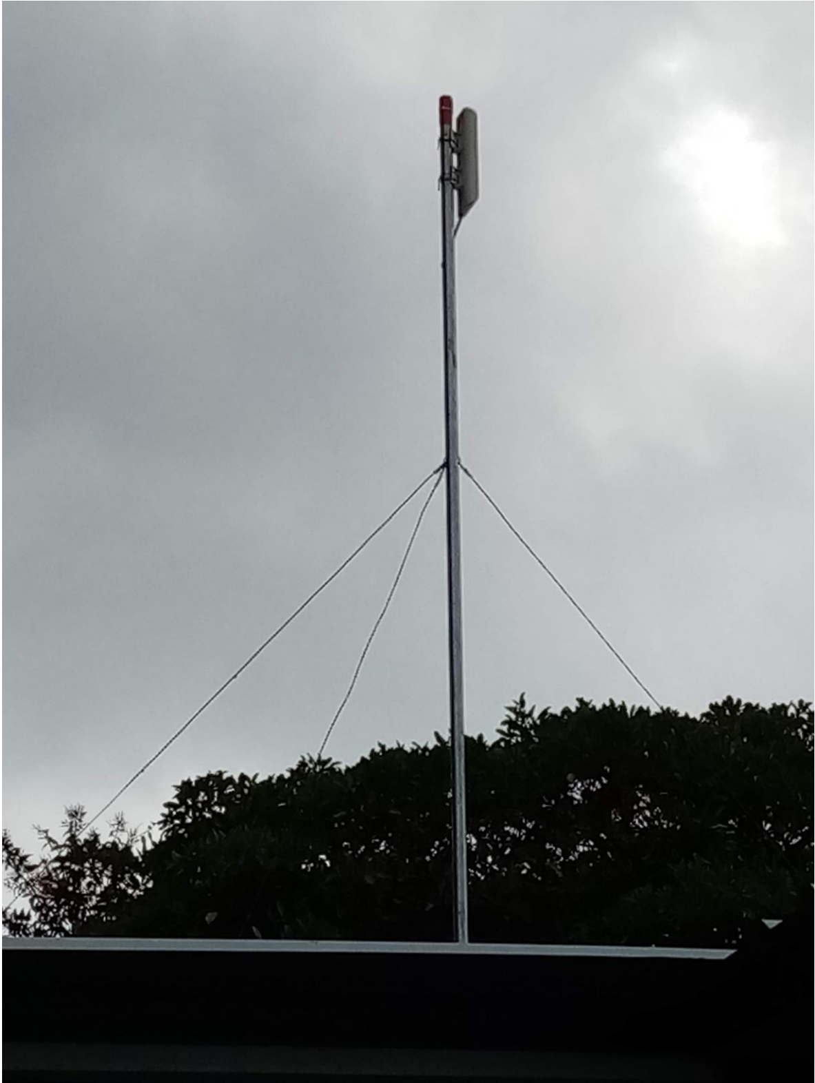
Ilustración 28 Repetidor para conexión a internet por radio enlace en la clínica universitaria
