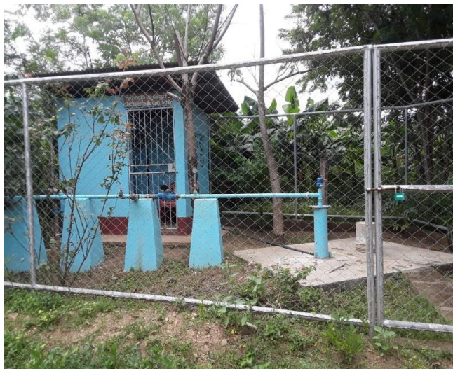
Imagen 11. Pozo de agua potable de la comunidad, fecha: 17 de agosto 2020.
