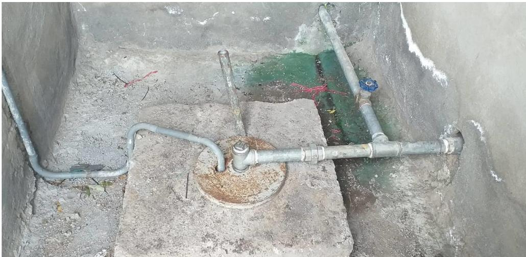
Sistema de extracción de agua del pozo mediante tuberías que conducen a los tanques de almacenamiento.
