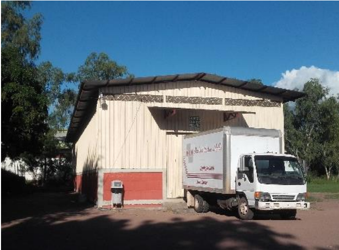
Imagen 18: Bodega de recepción de materia prima.
