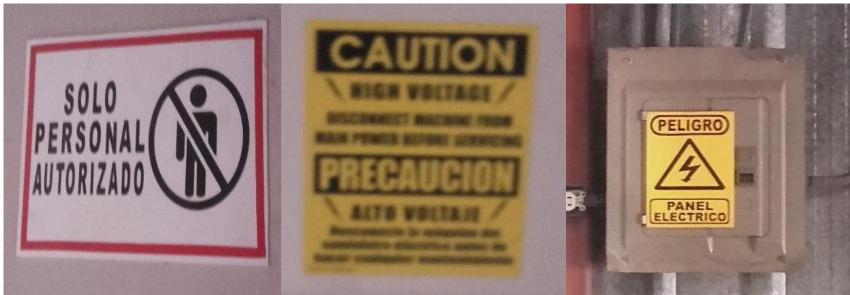
Imagen 17: Señalizaciones más comunes encontradas en la cooperativa.
