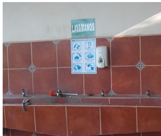
Imagen 25: Lavamanos en área de comedor.
