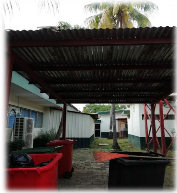
Figura No. 30. Área de almacenamiento temporal entre pasillos.
