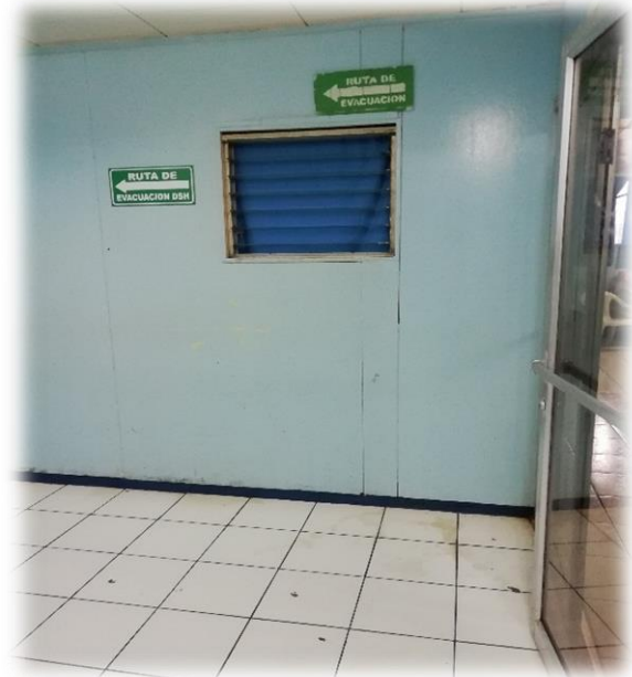
Figura No. 50. Etiquetado inadecuado de las rutas sanitarias de los residuos hospitalarios.
