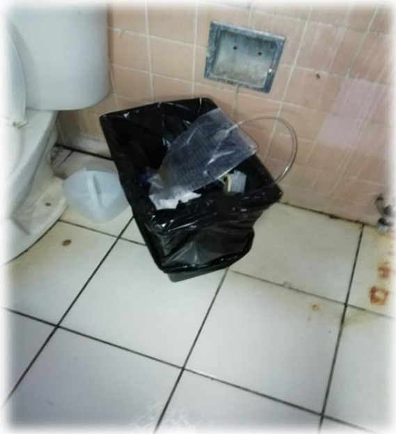
Figura No. 29. Depósito de Residuos comunes ubicado en servicios higiénicos con Residuos Bioinfecciosos.
