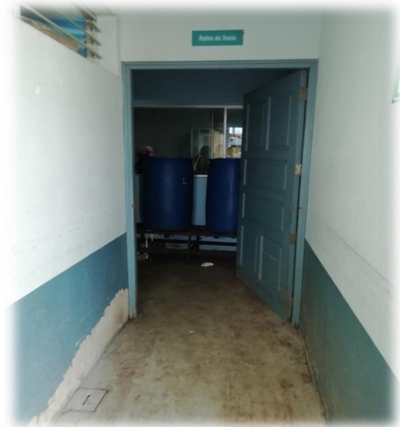
Figura No. 38. Área de almacenamiento temporal de Salas de Operación.
