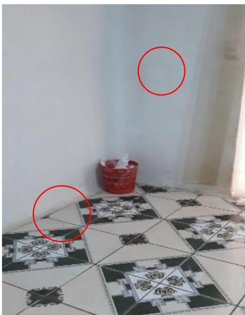
Figura 14: Piso con curvatura sanitaria y paredes lisas de color claro
