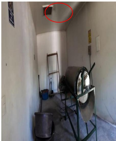
Figura 18: Extractor de vapores en el área de tostado o trituración
