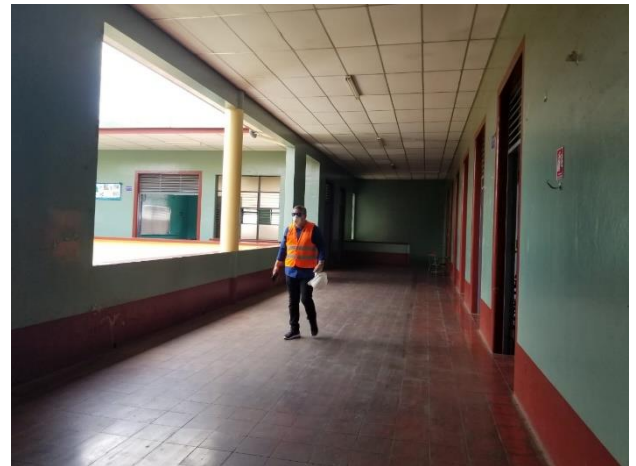
Fotografía 8 Pasillo, 2da Planta del ICCVB, Mayo, 2020.
