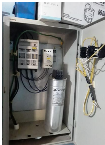
Ilustración 13 Banco de Condensadores
