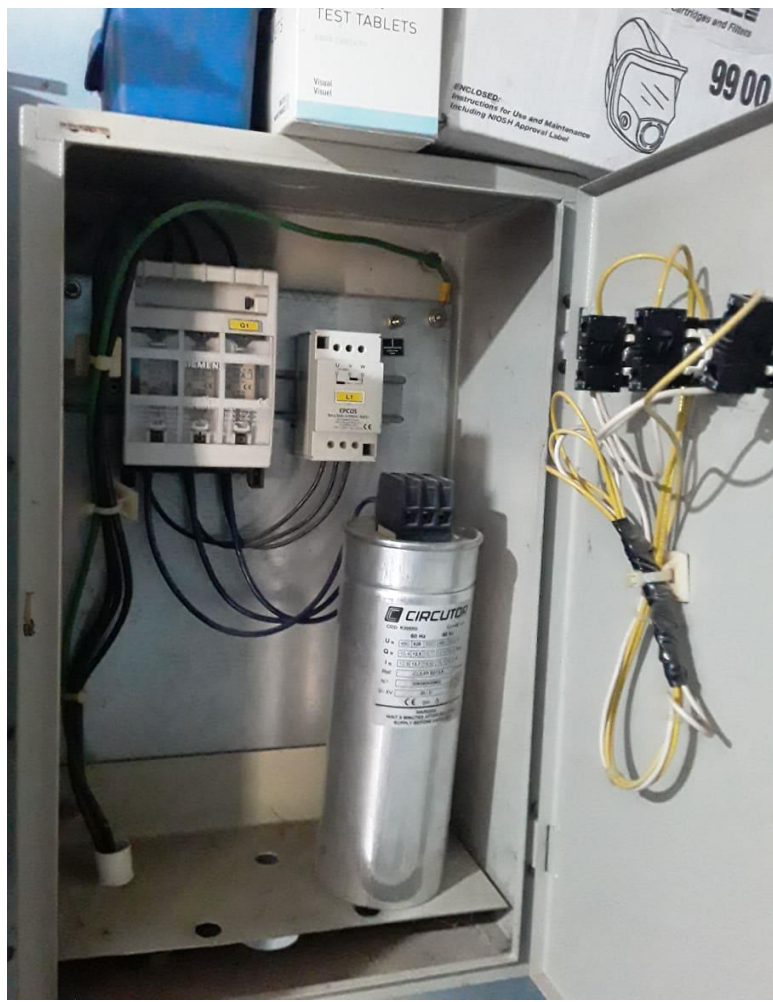
Ilustración 26 Banco de Condensadores
