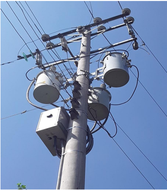
Ilustración 25 Banco Transformadores
