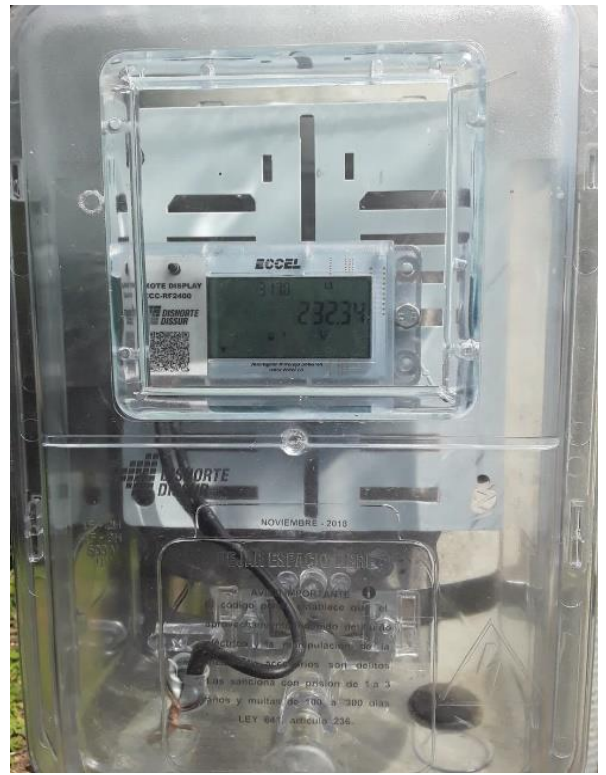
Ilustración 24 Medidor Eléctrico
