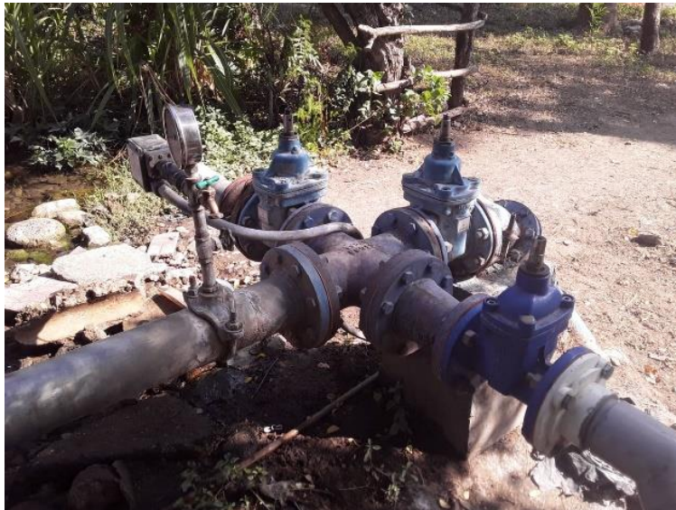
Ilustración 11 Válvula de Compuerta en mal estado
