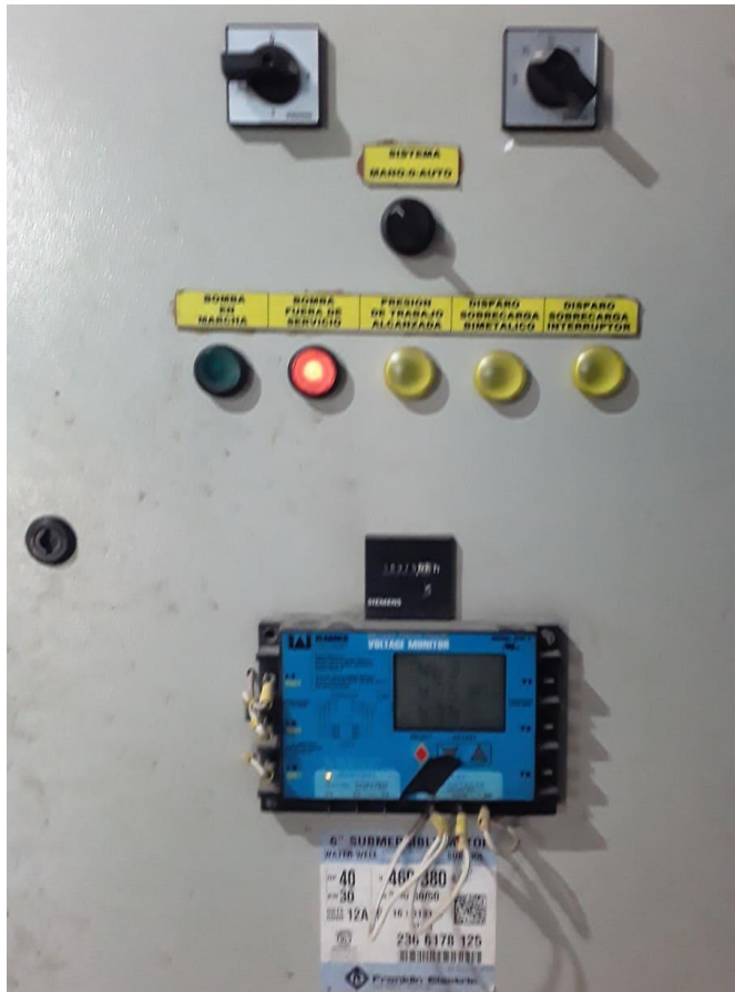
Ilustración 29 Panel de Control arracadores
