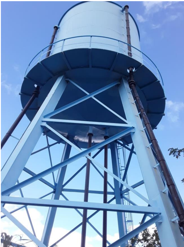
Ilustración 28 Tanque de Abastecimiento
