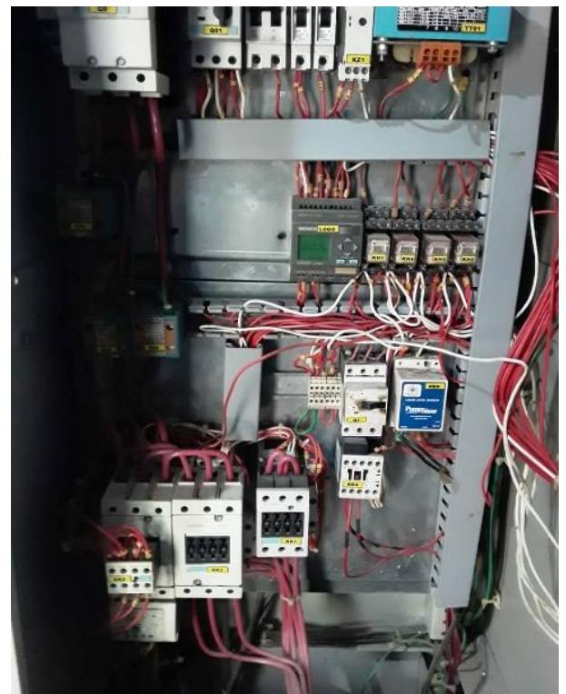
Ilustración 31 Panel de control y sus conexiones
