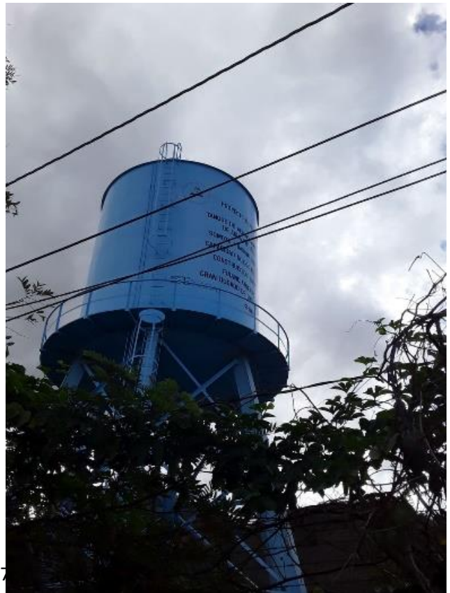
Ilustración 27 Tanque Ubicado en el Sector N°20
