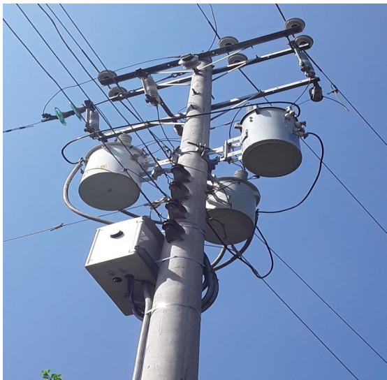
Ilustración 8 Transformadores
