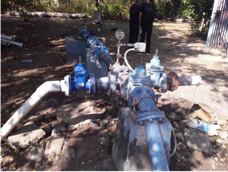
Ilustración 20 Visita a la Estación de Bombeo N°7
