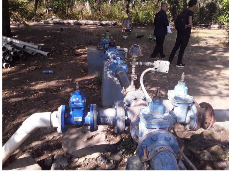
Ilustración 19 Zarta Instalada Hierro colado 6 pulgadas
