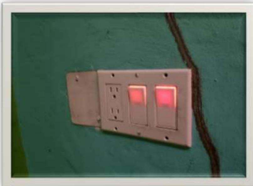
**Figura 37** apagadores los cuales evidencian el poco mantenimiento y la falta de implementación de buenas practicas
