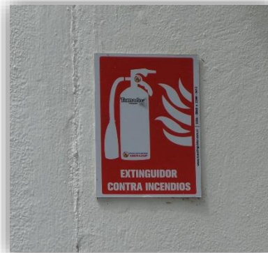
Imagen 12. Extinguidor contra incendios.
