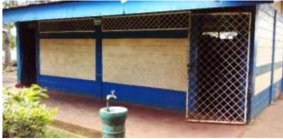
(Imagen 2) Pabellón de servicios sanitarios
