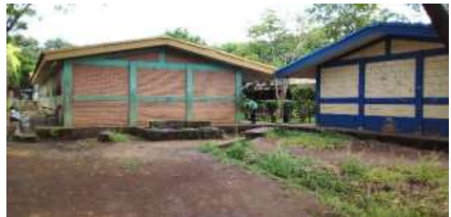
(Imagen 1) infraestructura del colegio
