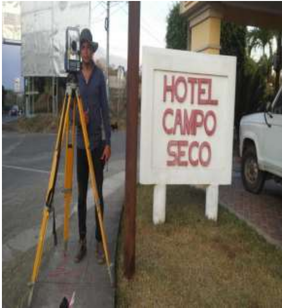
Ilustración 20 foto levantamiento de campo 25 de febrero 2019. Fuente: propia
