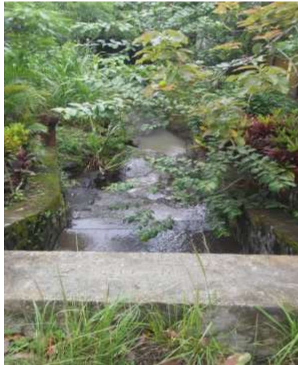
Ilustración 19 detalle cauce revestido. Fuente: propia
