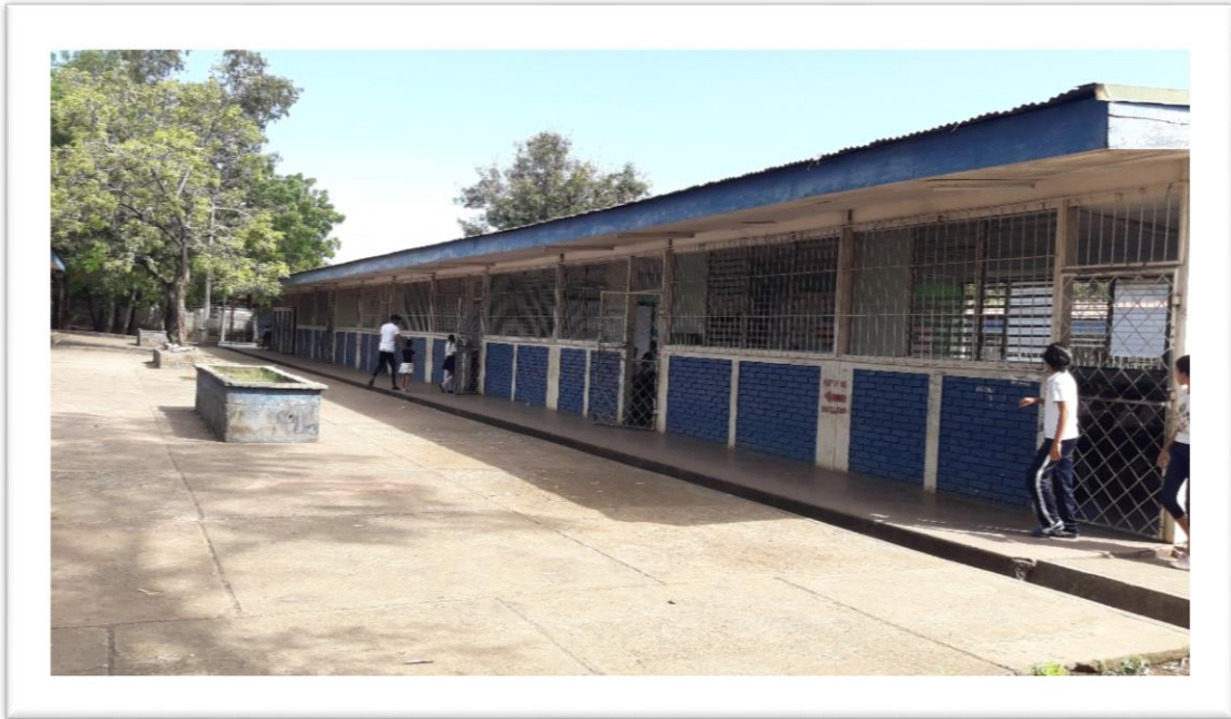
Foto N°11: Pabellón 3 de primaria.
