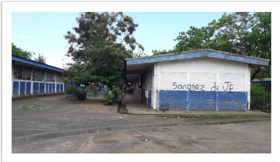
Foto N°12: Toma desde otra perspectiva del pabellón 3 de primaria.
