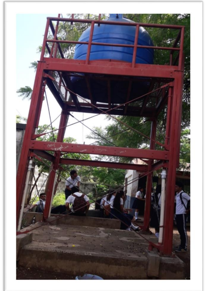
Foto N°21: Tanque de Agua
