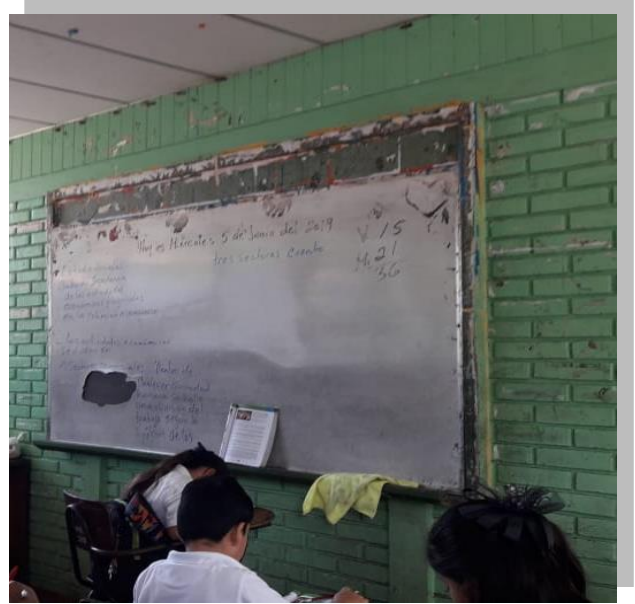
Foto N°7: Condiciones de la pizarra.
