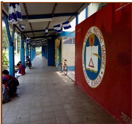
Fotografía 15 Pasillo externo del auditorio
