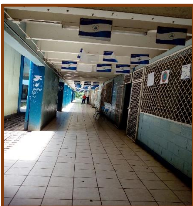
Fotografía 17 pasillo planta baja
