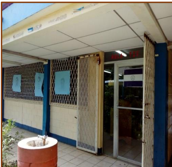
Fotografía 27 Entrada a la Aula TIC
