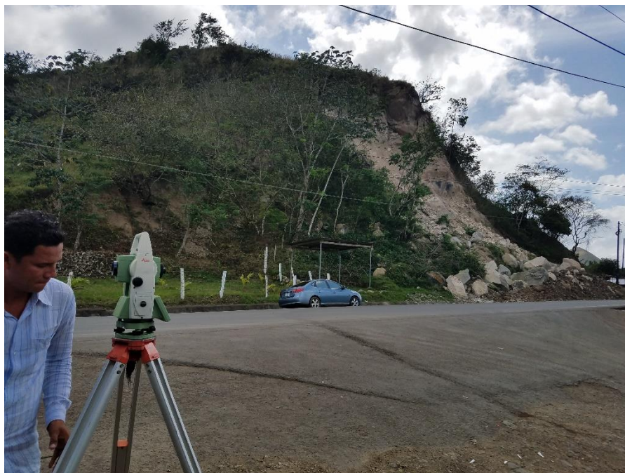
Foto 1. Km 176 carretera Nic-7. Coordenadas UTM-WGS84: N1335031 E707110. Fuente: elaboración propia.
