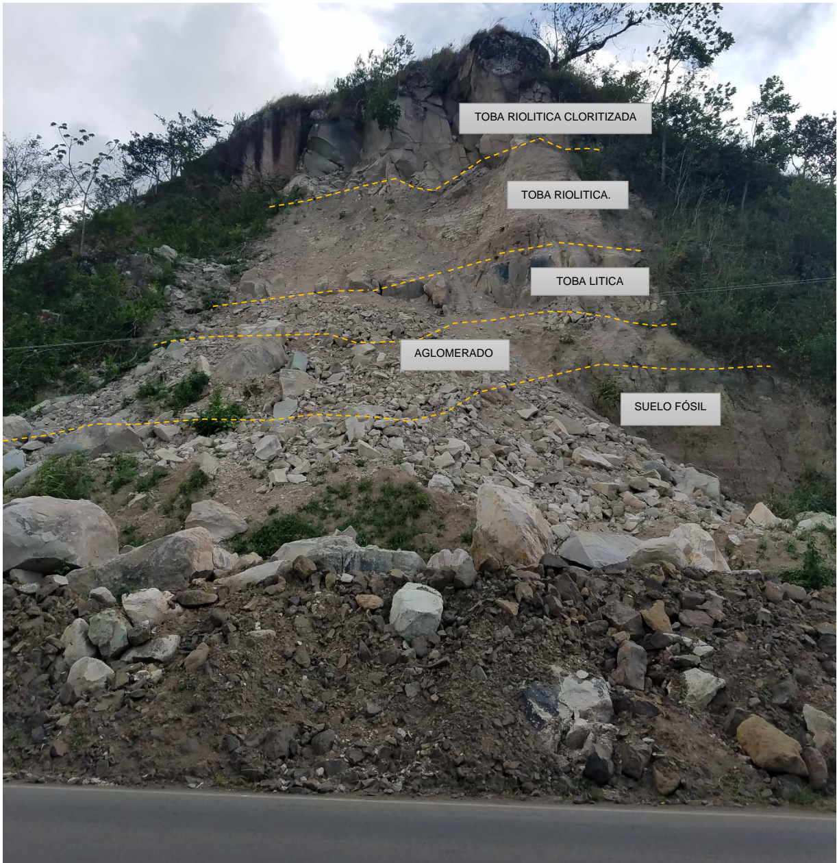
Foto 3. Litología del talud. Coordenadas UTM-WGS84: N1335014 E707068. Fuente: elaboración propia.
