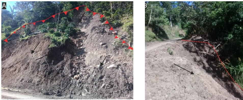
Foto 44. Deslizamiento rotacional en las coordenadas 638267/ 1402553, afectando el camino que conduce a la comunidad La Luna.
