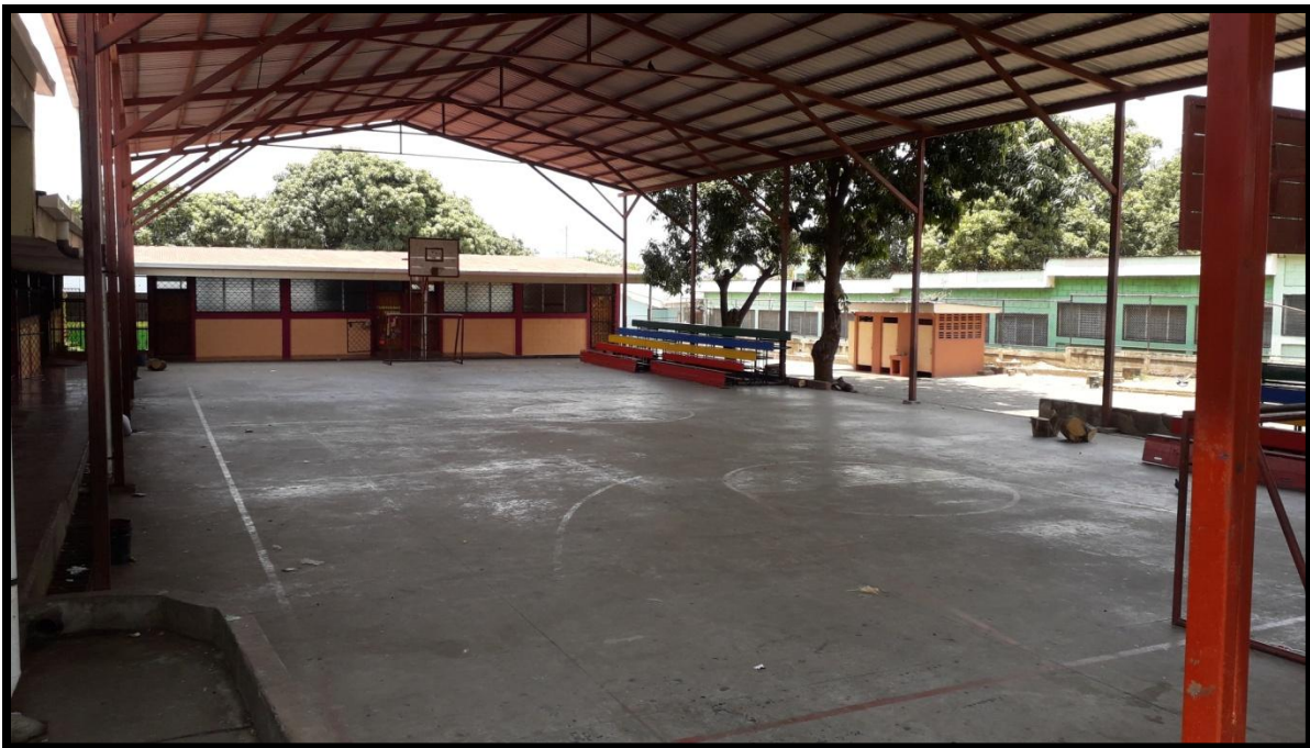
CANCHA MULTIUSO DE PRIMARIA
