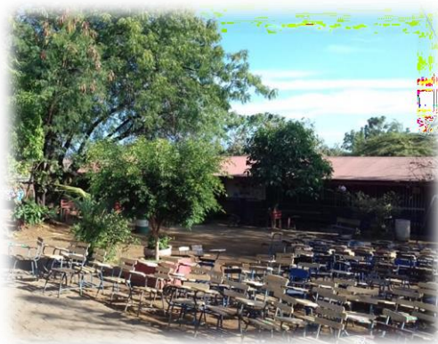
Ilustración 2 Pabellón de Secundaria, Colegio Público Martha Lorena.
