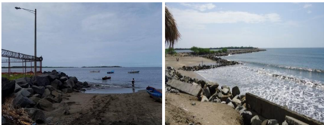
Fig.3 – 4 De izquierda a Derecha: Malla de protección del puerto- Barrio costero Municipio de Corinto Fuente: Propia
