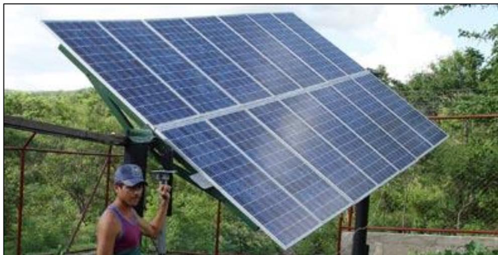
Figura 2: Módulo solar FV del miniacueducto por bombeo solar de la comunidad El orégano, Santa Lucia, Boaco.
