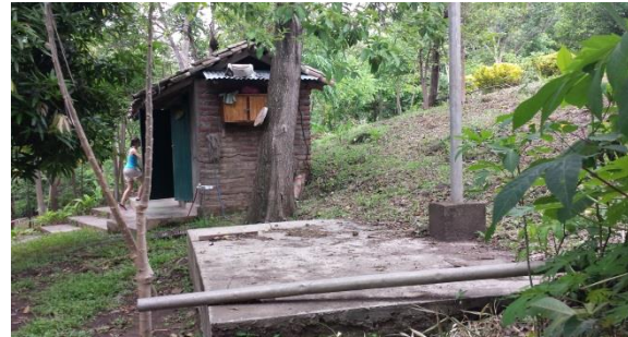
Fig. No 14: Servicios Sanitarios y Fosa Séptica
