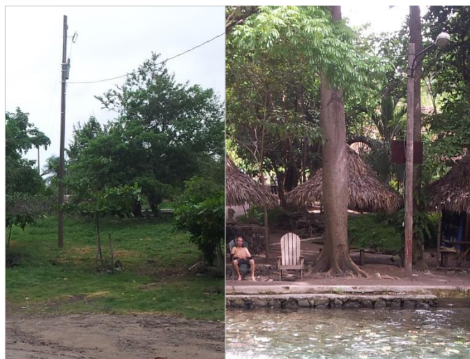
Fig. No 15: Postes de la acometida eléctrica
