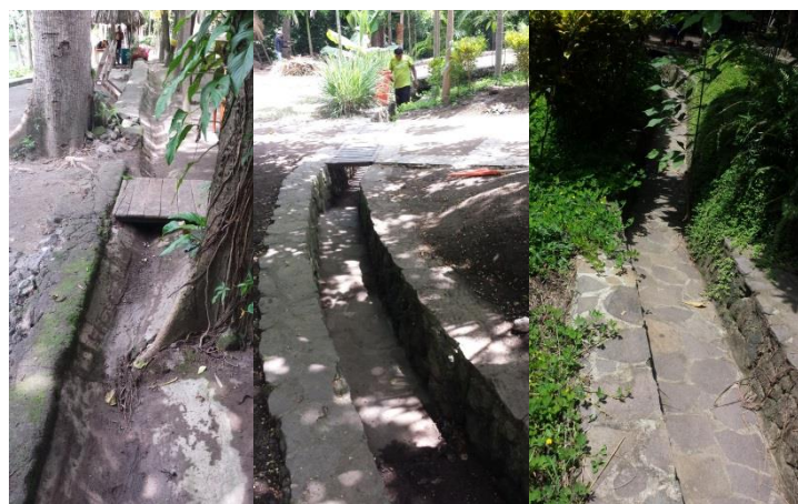
Fig. No 13: Revestimiento de Cauces naturales
